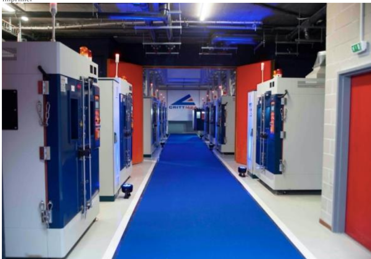
Aperçu du GTC du Critt M2A et du Crepim
