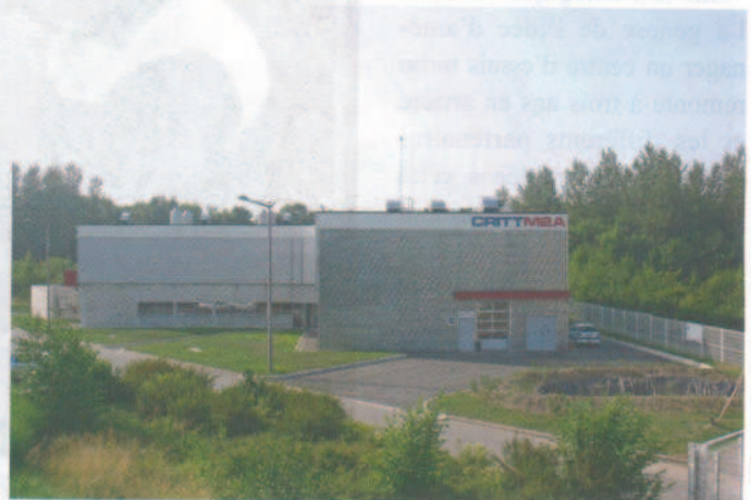
L'extension du centre de recherche porte sur une surface de 1 400 m 2 .
