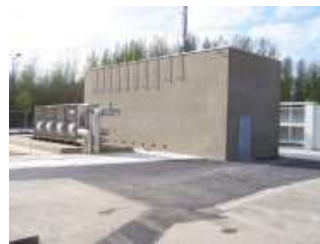
Modernisation réseau carburant (10 carburants gérés simultanément)
