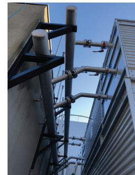
Afin d'obtenir des températures en sortie d'échangeur de plus en plus froides, le CRITTM2A dispose également de 3 groupes d'eau glacée d'une puissance frigorifique totale supérieure à 1 MW. L'eau glacée est régulée à 8°C pour les bancs moteurs et le banc 4 machines. Cette application est également utilisée au centre d'essais turbo pour réguler la température d'air en entrée compresseur.
